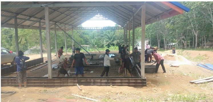
후왜이행 교회 지붕 공사 후 최근에 힘을 모아 바닥 콘크리트 공사를 자체적으로 함.
