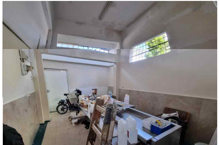
무료 급식소 리모델링 공사 현장
